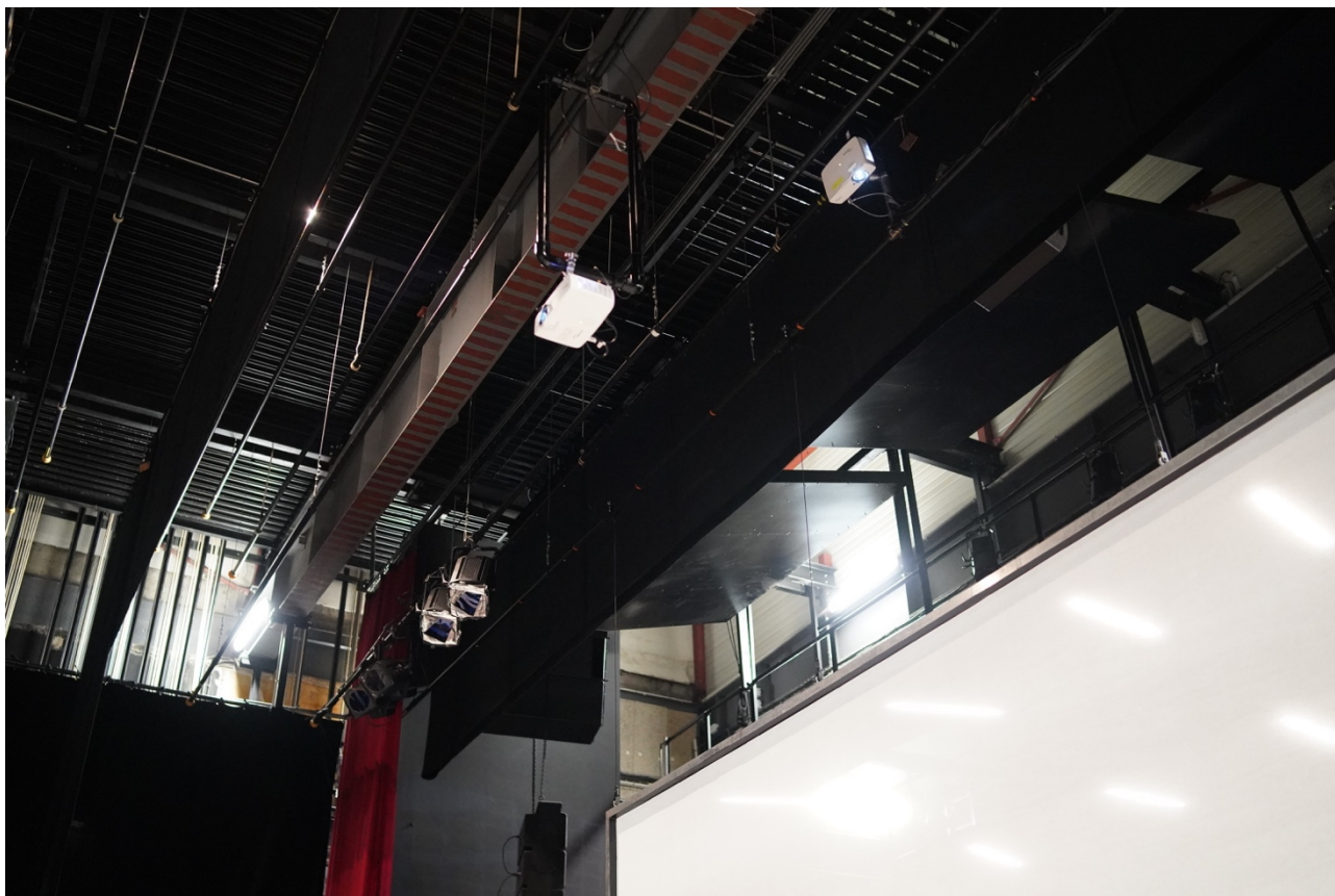
Fig. 4 : Photo de l'installation des vidéo-projecteurs
